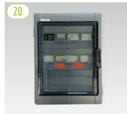
20 Distribución de energía de emergencia trifásica
